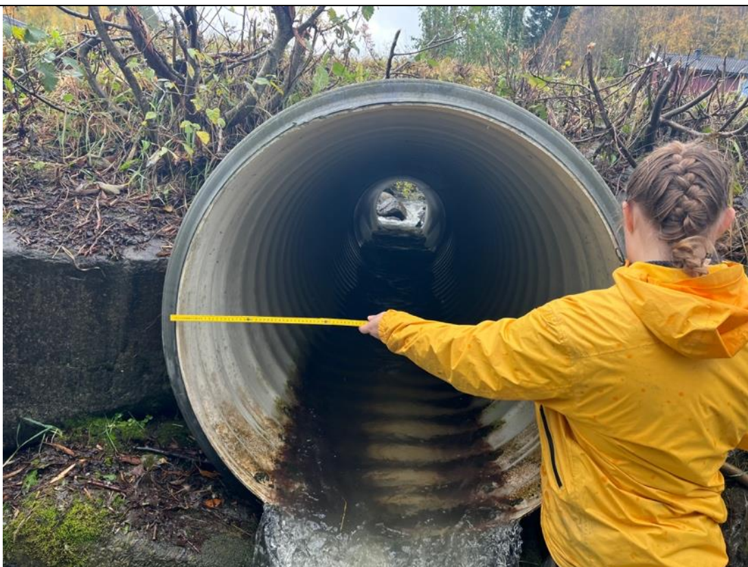
Måling av kulvertstørrelse i Kvellstadbekken.
