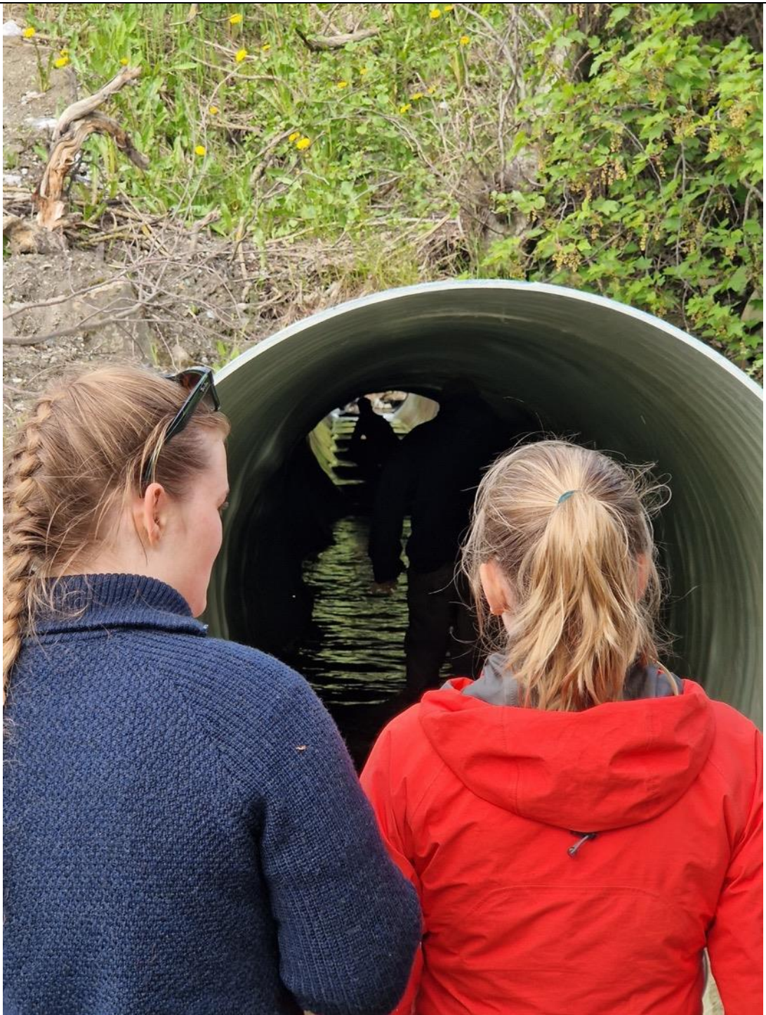
Diskusjon om kulvertens fremkommelighet
