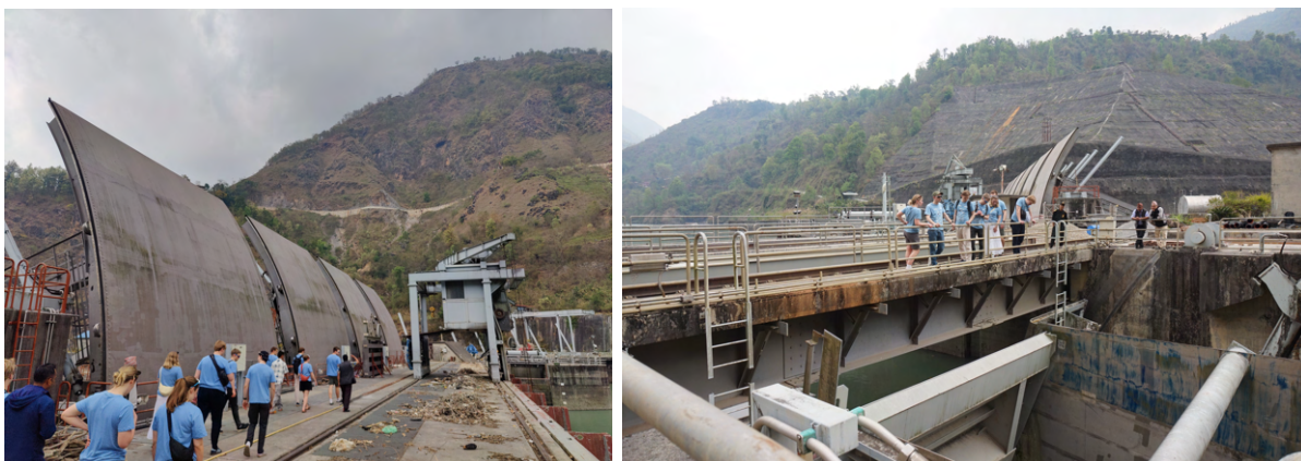
Inntakslukene til oppsamlingsbassenget for sedimenter på Kaligandaki vannkraftverk
