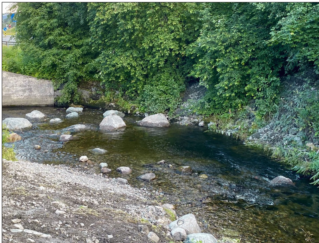
Foto 7. Flom har fordelt gytesubstrat i elveløpet (t.v.), og stor stein plassert ut for å bremse unaturlig høy sediment-transport og danne gode gyte- og oppvekstområder for ungfisk.
