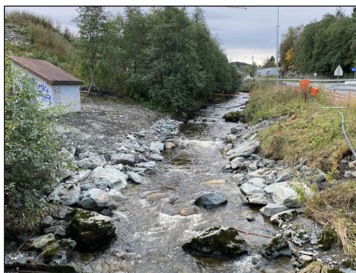
Foto 10. Fjerning av en utrangert vannmålestasjon i betong (øverst t.v., før status) oppført i årene 1992-93. I 2022 (bilde t.h.) ble naturlig vandringsvei gjenopprettet for alle størrelser av sjørret og laks i nedre del av Leirelva. Nederst t.v. viser status etter endt anleggsarbeid.
