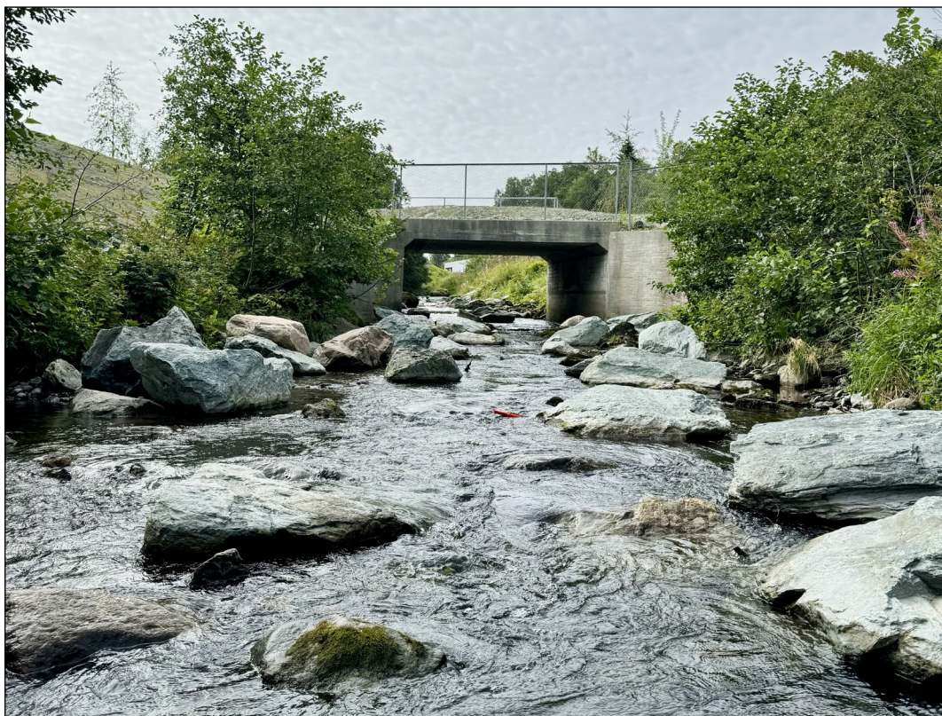
Foto 6. Utlegging av storstein/blokk i nedre del av Leirelva før samløp med Nidelva. Før (øverst) og etter (nederst) tiltak. Dette elvepartiet er det samme som er vist i historisk foto fra 1875 (foto 1).
