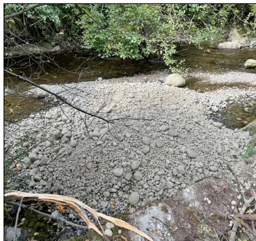
Foto 2. Deponier fra 10- 150 m 3 med gytesubstrat legges ut både i og langs hele elva på steder man kommer til, slik at flommer kan fordele substratet naturlig i elva. Foto fra utleggsområder i Leirelva.
