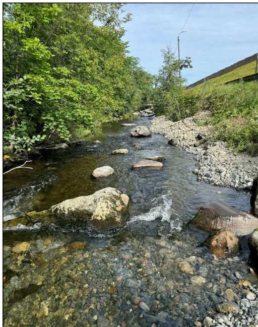
Foto 2. Deponier fra 10- 150 m 3 med gytesubstrat legges ut både i og langs hele elva på steder man kommer til, slik at flommer kan fordele substratet naturlig i elva. Foto fra utleggsområder i Leirelva.
