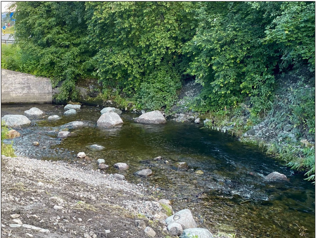
Foto 7. Flom har fordelt gytesubstrat i elveløpet (t.v.), og stor stein plassert ut for å bremse unaturlig høy sediment-transport og danne gode gyte- og oppvekstområder for ungfisk.
