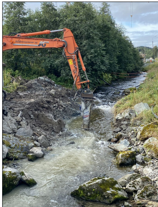
Foto 10. Fjerning av en utrangert vannmålestasjon i betong (øverst t.v., før status) oppført i årene 1992-93. I 2022 (bilde t.h.) ble naturlig vandringsvei gjenopprettet for alle størrelser av sjørret og laks i nedre del av Leirelva. Nederst t.v. viser status etter endt anleggsarbeid.
