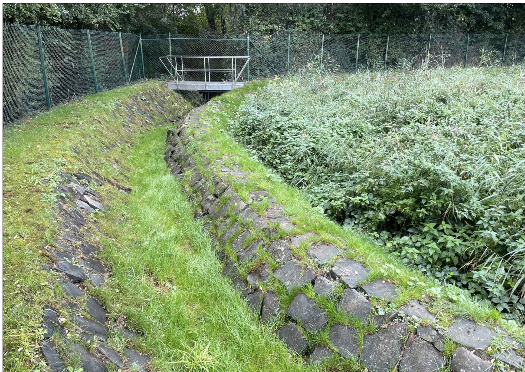
Figur 14. Overløp fra filter 2, samt renne for renset overløpssvann til bekk.
