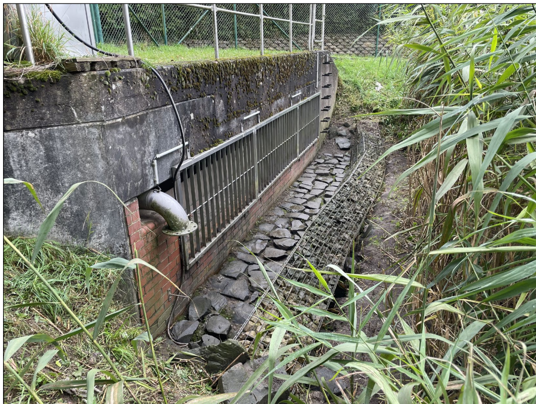
Figur 12. Innløp til det første VBO filteret. Steiner er lagt som en beskyttelse mot erosjon, og en gabionterskel for å redusere vannhastigheten inn i filteret. I utgangspunktet skulle like mye vann fordeles til de to filterene, men i praksis fikk det ene litt mer enn det andre.
