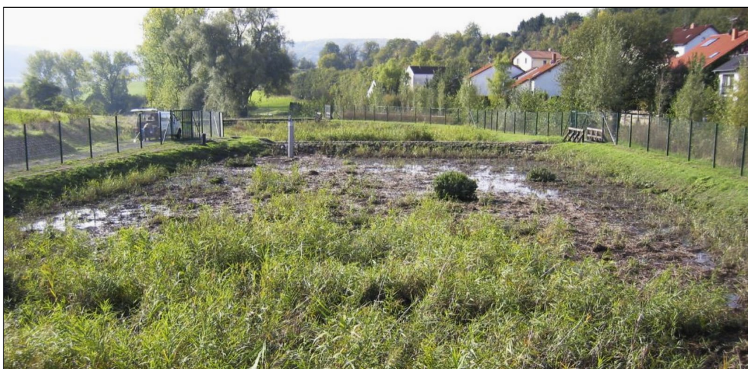
Figur 11. Mangel på vann kan gi misvekst spesielt på nyetableringer (foto fra Dittmer).
