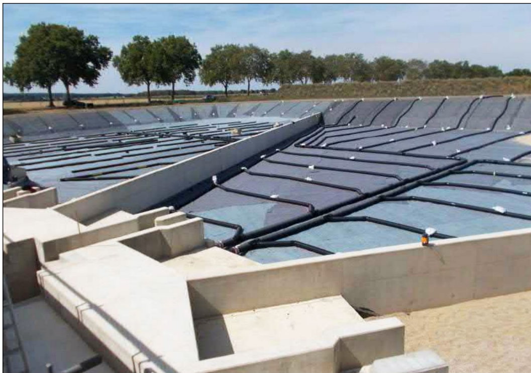
Figur 6. Filtrene har membran mot grunnvannet og er drenert. Drensvannet ledes mot tre pumpekummer som sender vannet til bekken. Bilde av ATD-Aachen.
