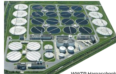
WWTP Harnaschpolder - Delft
