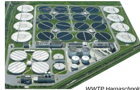
WWTP Harnaschpolder - Delft
