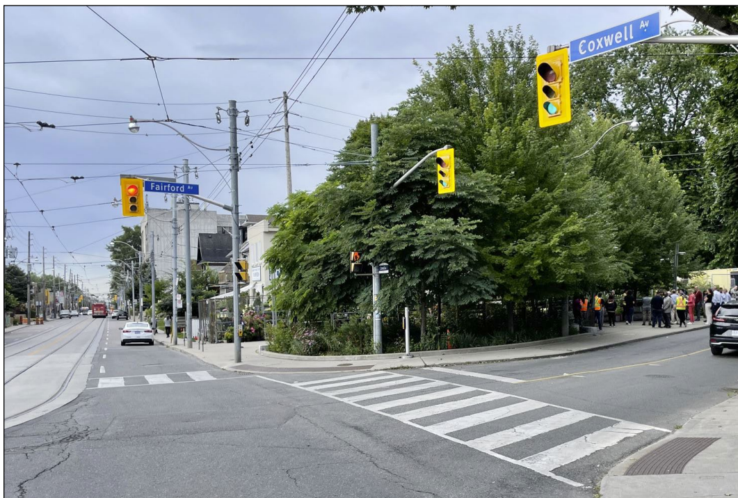
Figur 6. Nytt kryss med minipark som mottar overvann fra gate (Foto: B.C. Braskerud).
