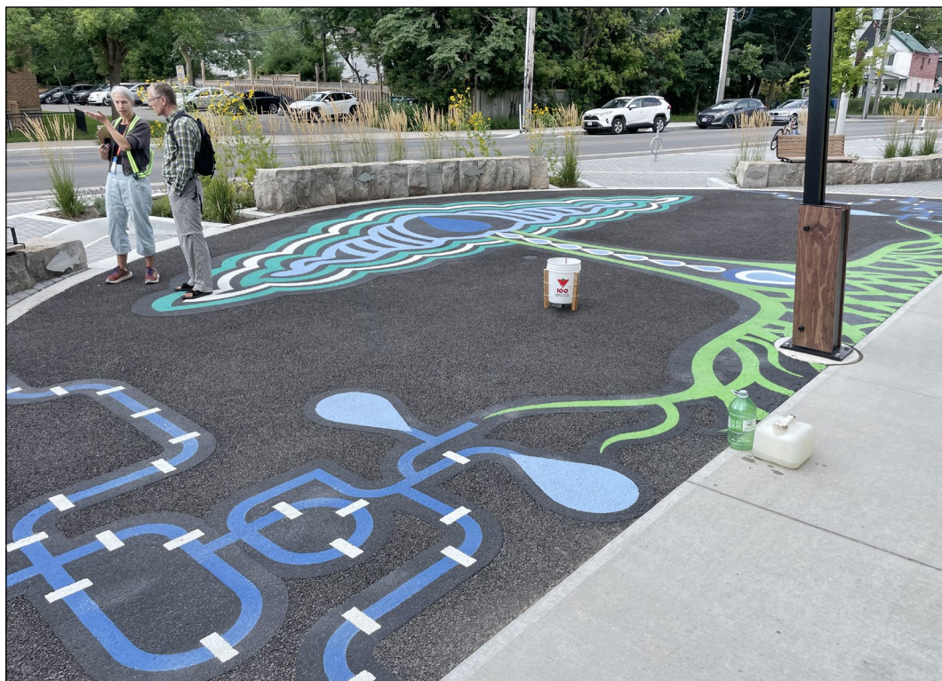
Figur 8. Bildet på den permeable asfalten heter «Where the water flows», og er laget av kunstneren Dan Bergeron i samarbeid med den lokale barneskolen. Legg merke til den hvite bøtta midt på bildet. Den ble brukt til å teste infiltrasjonsevnen på overflata; se tekst (Foto: B.C. Braskerud).
