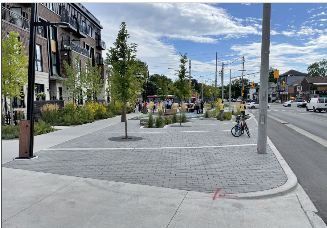
Figur 7. Raindrop plaza med trær, regnbed som samler vann fra gata og ledes til en underjordisk tank for selvvanning (Foto: B.C. Braskerud).
