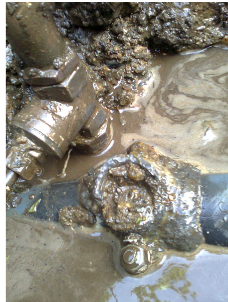
Anboring på felles stikk ledning. Felles ledning i PVC, anboringsklamre i aluminium og plast.
