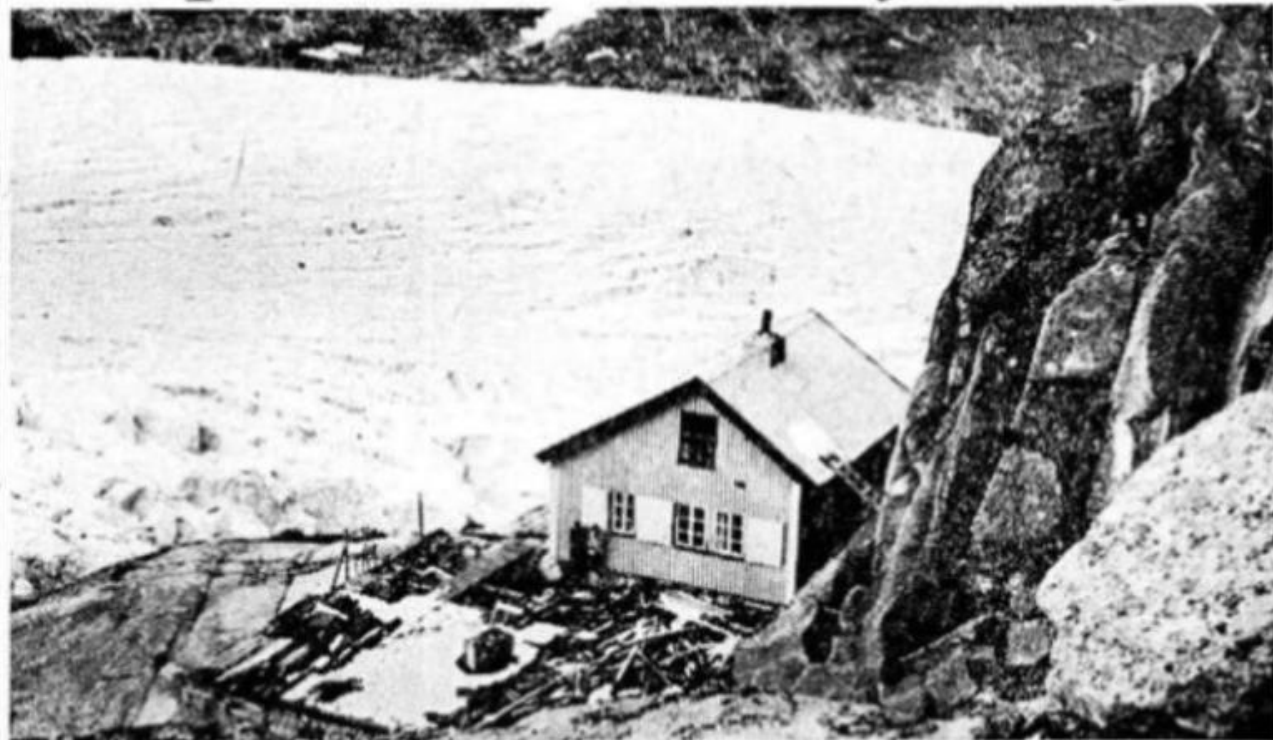
Demmevasshytta på Hardangervidda er gjenåpnet. Den ligger 1313 m.o.h., og breen Rembedalsskjåkje er dens nære nabo. Den del av hytten som ble bygget i 1910 er nu revet, og den eldste del, bygget i 1899, er utvidet
