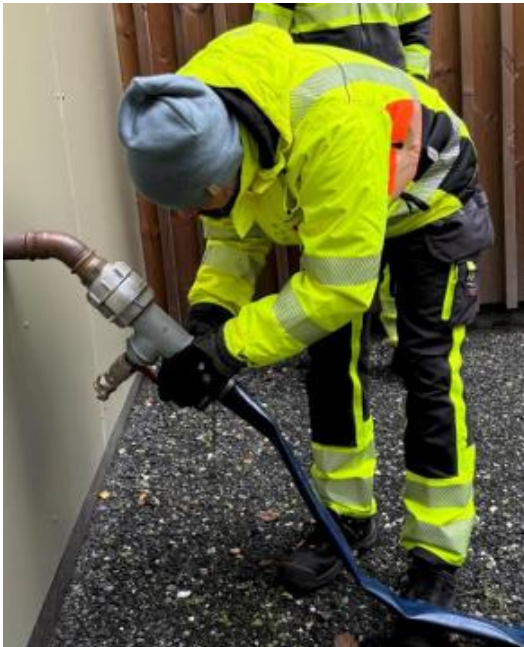
Nybygg: Påkoblingspunkt på yttervegg
