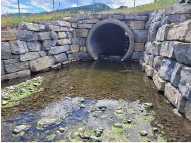
Bilde 8. Innløp av betongstikkrenne sett i fra sør. Steinlagt vingemur.
