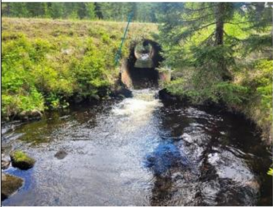
Bilde 46. Under fv. 215 rant Hattbekken i en Ribbekulvert av stål. Kulpen i nedkant var stor, men spranget opp til kulverten var høyt.
