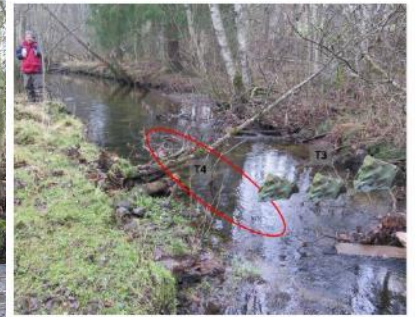
Figur 31. Utlegging av steingrupper (T3) for å øke vannhastighet mot ryvelstøbt gyteområde (T4) ved sone 16 – tiltaksområde 3.
