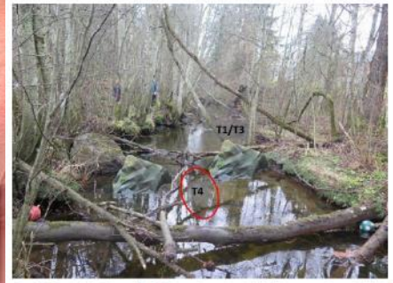
Figur 30. Sone 14 – tiltaksområde 2. Utplassering av stor stein for å skape egnet vannhastighet til gyting, samt utlegging av gytegrus på hydrologisk egnet lokalitet.
