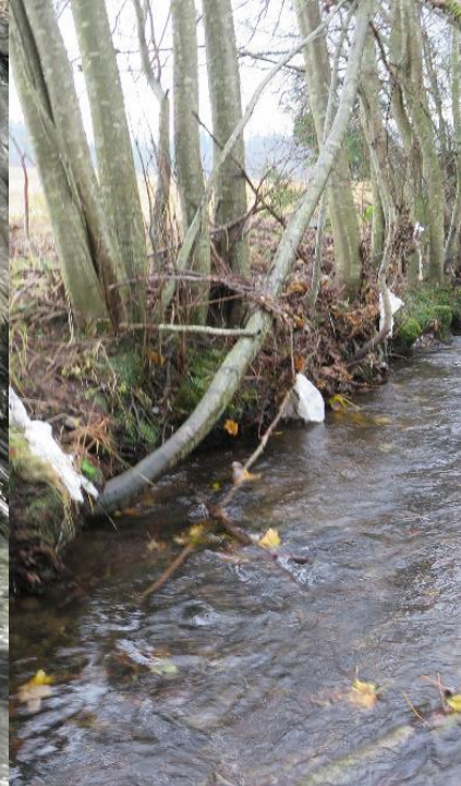
Figur 30. Sone 14 – tiltaksområde 2. Utplassering av stor stein for å skape egnet vannhastighet til gyting, samt utlegging av gytegrus på hydrologisk egnet lokalitet.
