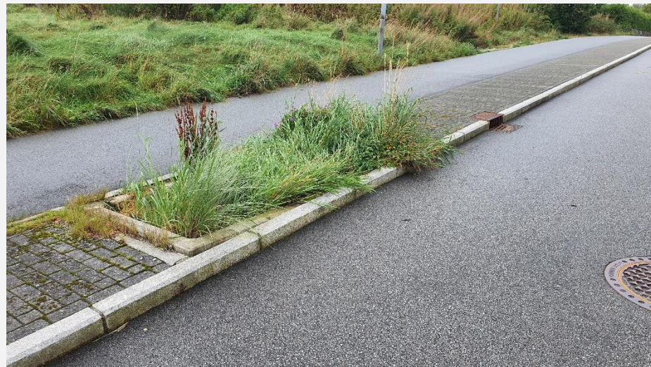
Type 321 – Innløp via sandfang
