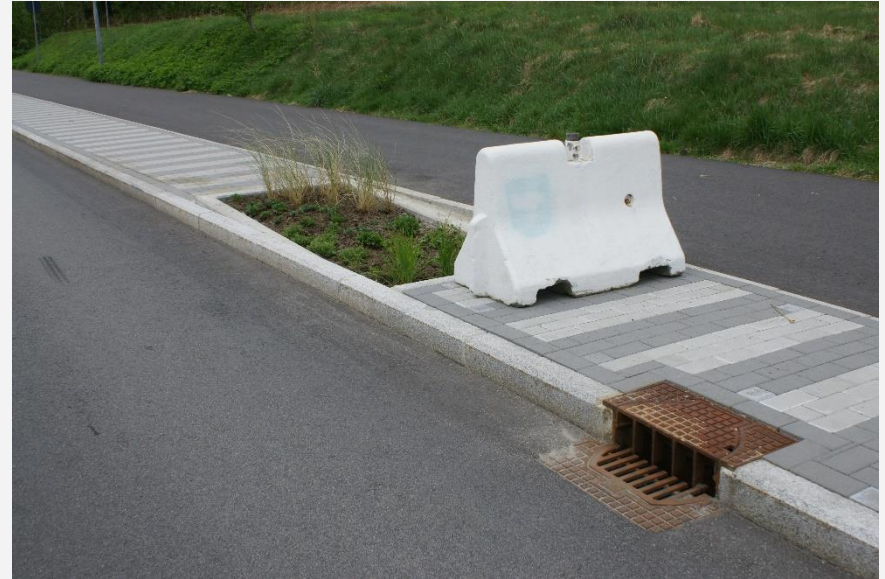
Type 321 – Innløp via sandfang
