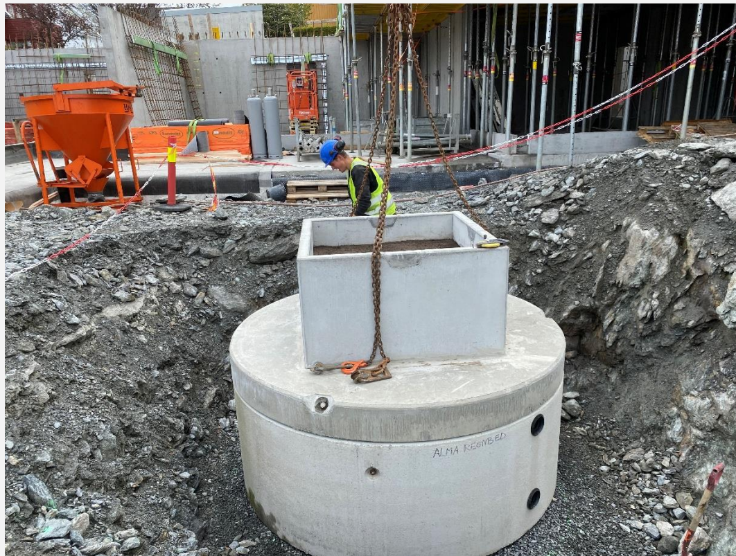
Alma regnbed type 224. Spesial-modell med 5 m 3 fordrøyningsvolum
