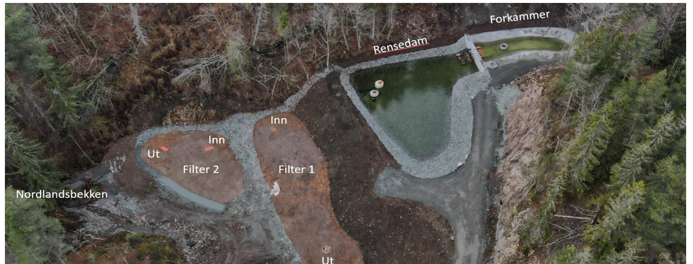
Norlandsdalen nitrogenrenseanlegg for avrenning fra sprengstein -Sollihøgda
