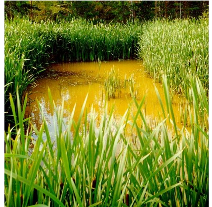
Rensedam og våtmark for deponisigevann. Spillhaug i Aurskog Høland
