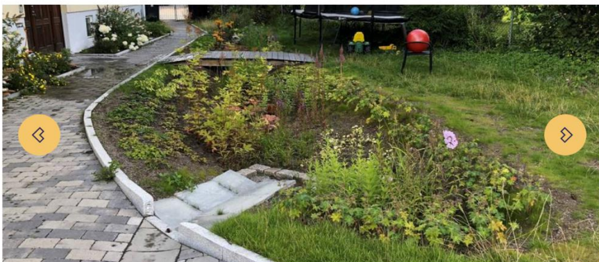
Regnbud er et blomsterbed som kan holde på vann midlertidig (Grefsenveien 105)
