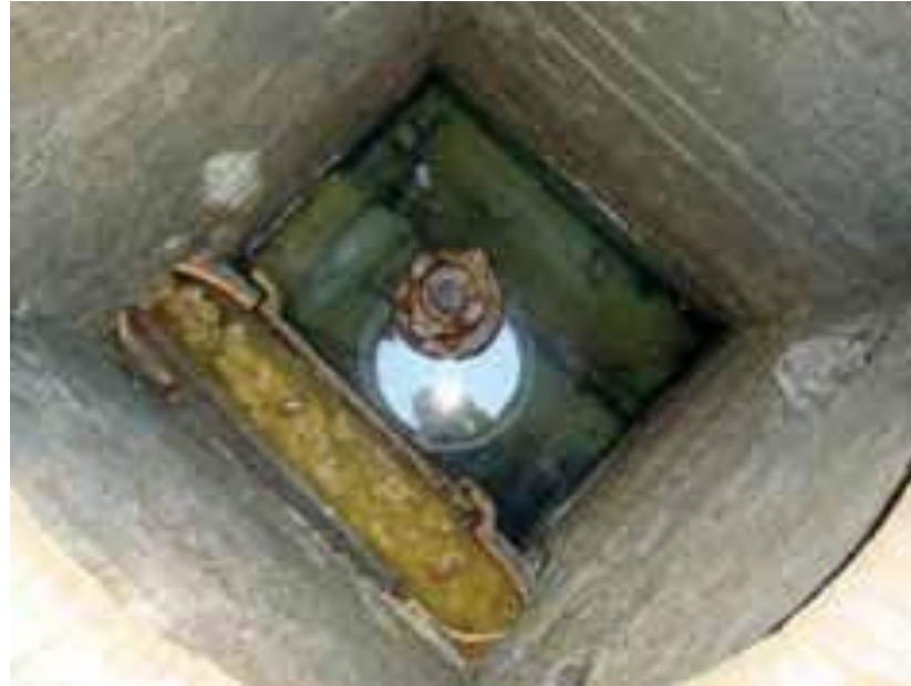
Foto: Asplan Viak: Felleskum for vann og avløp risiko for forurensning av vannledningsnett uten full separering. VANN 03, 2011
