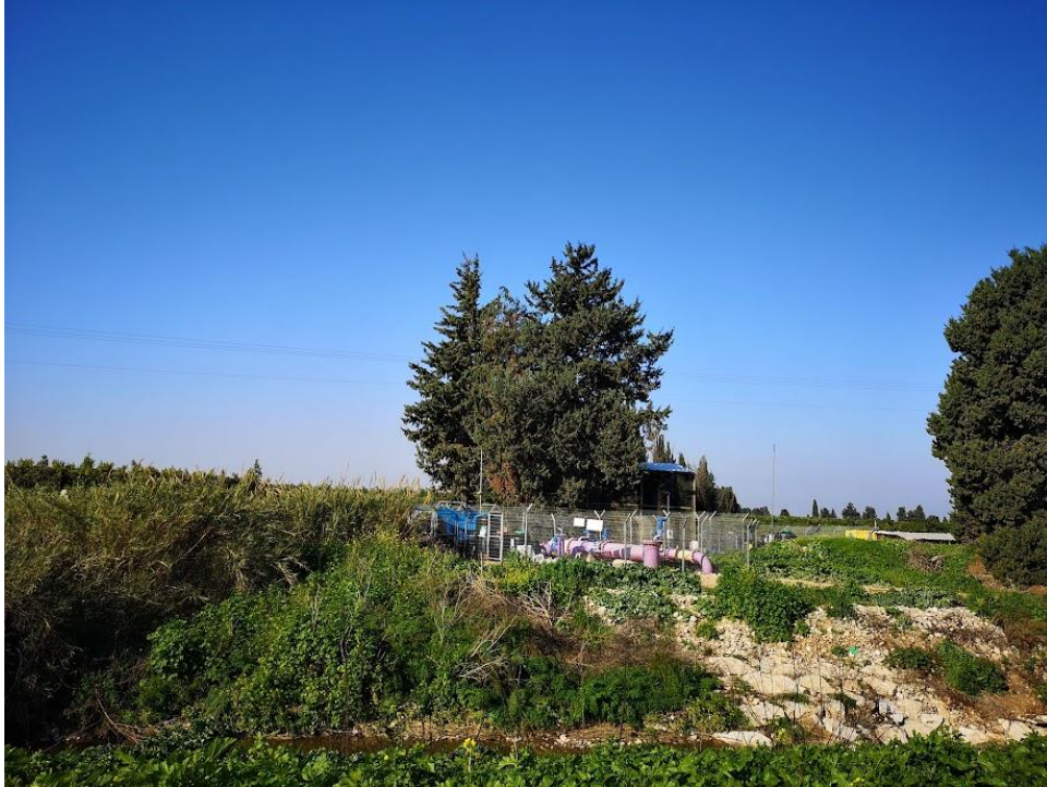
Karakteristiske lilla rør som fordeler behandlet avløpsvann til irrigasjon over hele landet.
