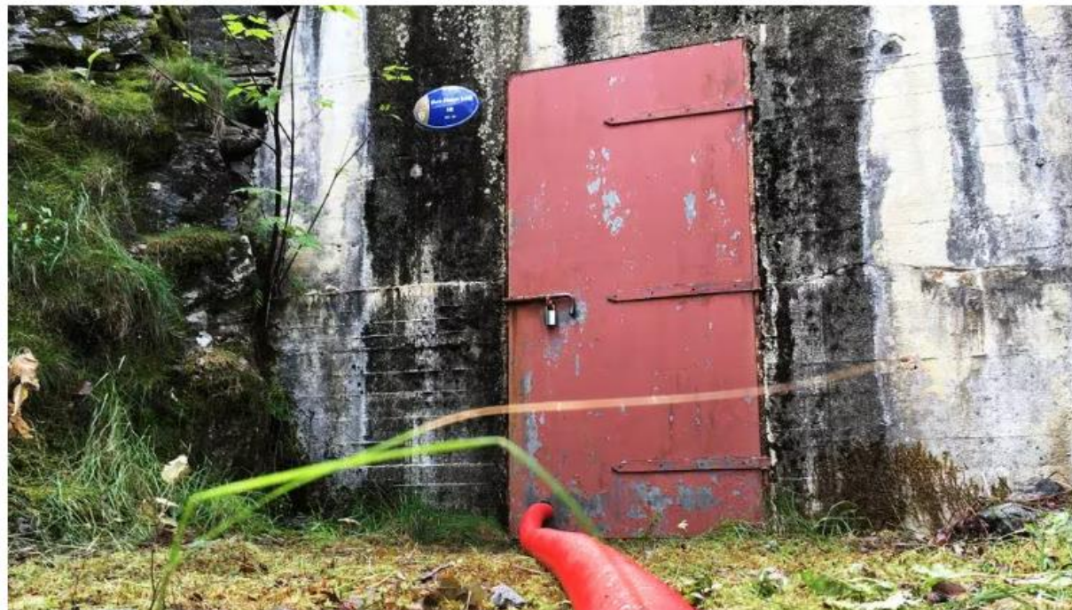
VANNPRØVER: Høydebassenget på Øvre Klepp har blitt faset ut og erstattet av et nytt høydebasseng.
