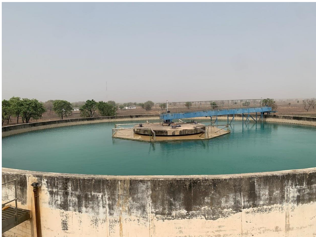
Sedimentasjonstank til drikkevannsrensing.
