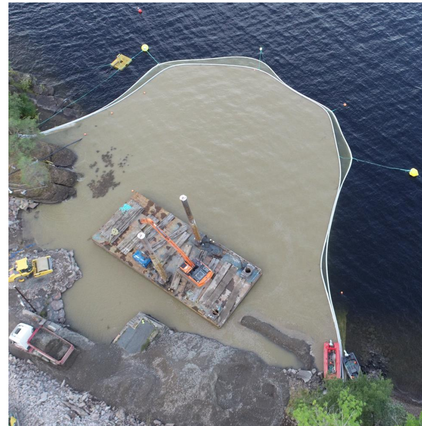
Foto: Mudring og utfylling i sjø (Håkon Olstad – Skanska Survey).
