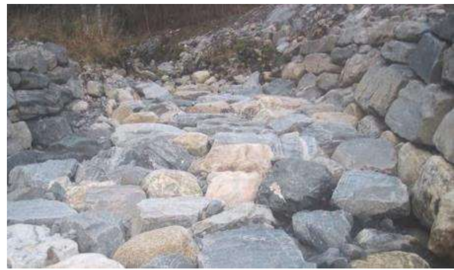
Nytt «elve»løp ved veibygging i Vestland, Foto: S.-E. Gabrielsen
