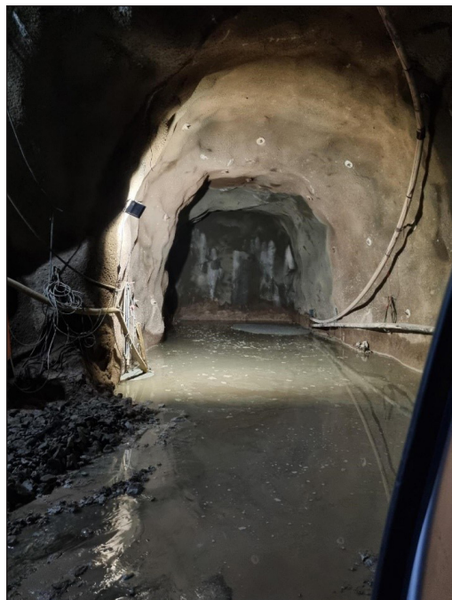
Figur 2. Slamprøver fra tunnel ble tatt fra innsiden av denne tunnelen. Foto: Sverre Hjelset
