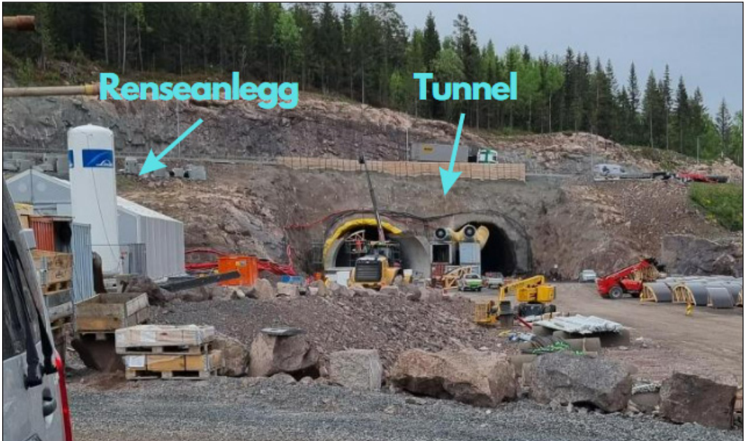
Figur 3. Renseanlegget og tunnelen der det ble tatt prøver. Foto: Sverre Hjelset
