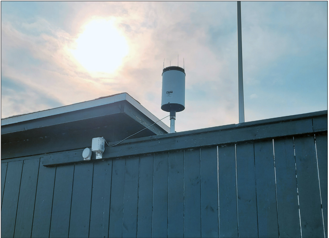
Figur 4. Lokal nedbørsmåler på badeplassen. Data samles inn og sendes elektronisk til NIRAS' varslingsserver, hvor de behandles i forhold til de konkrete forholdene på badeplassen.
