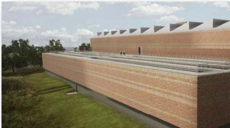
Foto: Alvim renseanlegg, Norconsult
