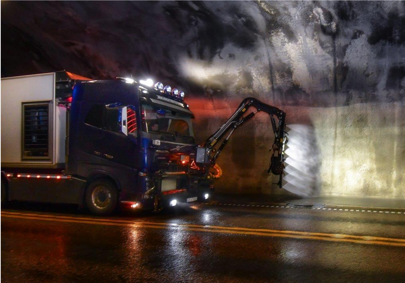
Foto: Knut Opeide, Statens vegvesen
