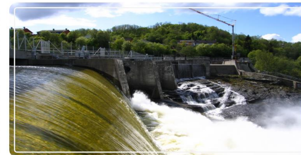
Øvre Leirfos Kraftverk. Foto: Jo H. Halleraker
