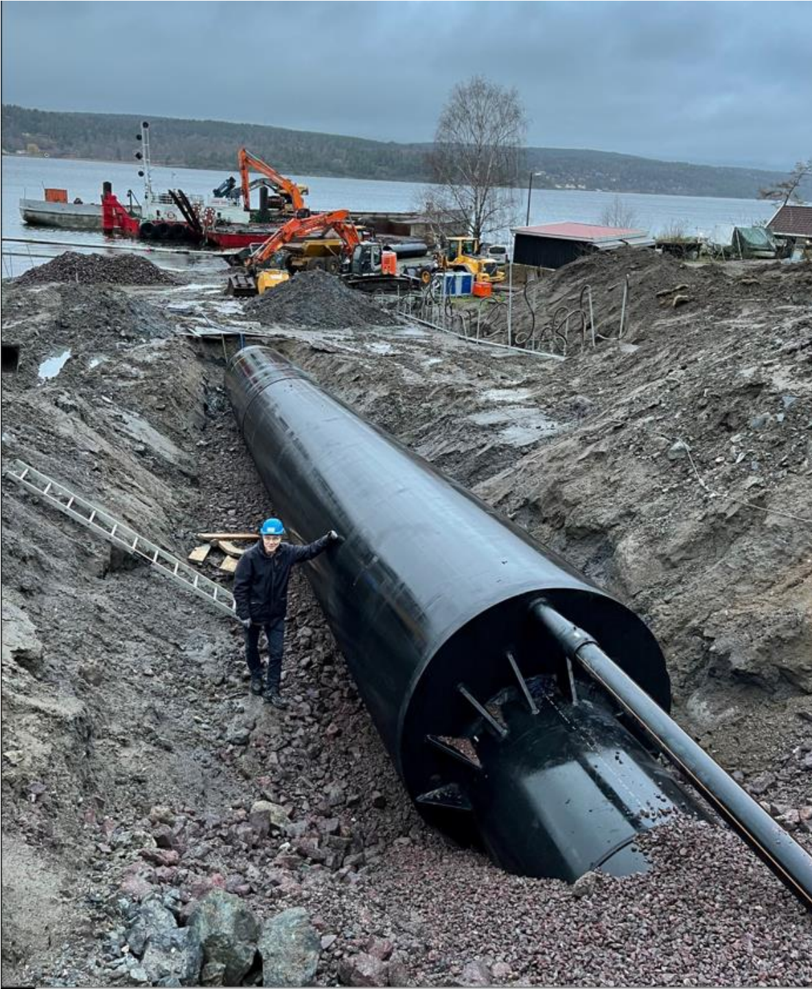
Daglig leder Bjørn Hånde v/NFRA, med luftfelle Ø2000 og belastningslodd Ø1000.
