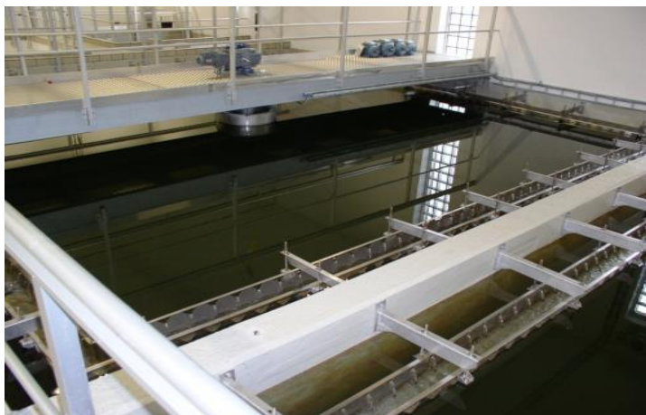
Koagulering - Filtrering Ca 120 anlegg
