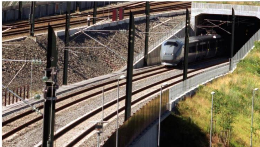
Romeriksporten gjør skade på hus og eiendom. FOTO: BØRGEN, ØRN E. / SCANPIX
