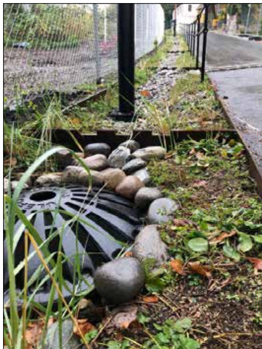
Overvannsløsning i Telthusbakken, Oslo.
