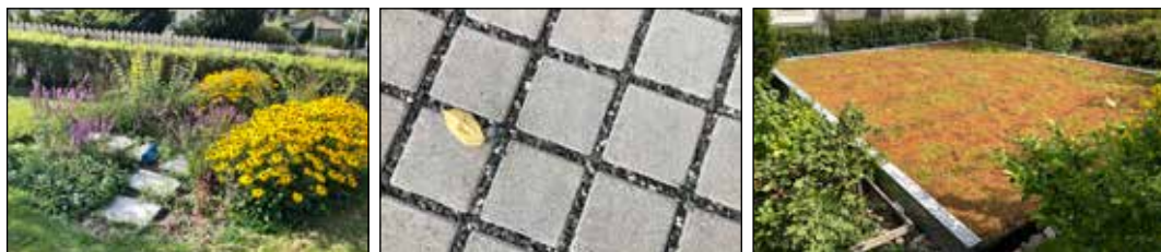
Figur 3. LOD-tiltak etablert i prosjektet. Fra venstre: regnbed, permeabel innkjørsel og grønt tak.
