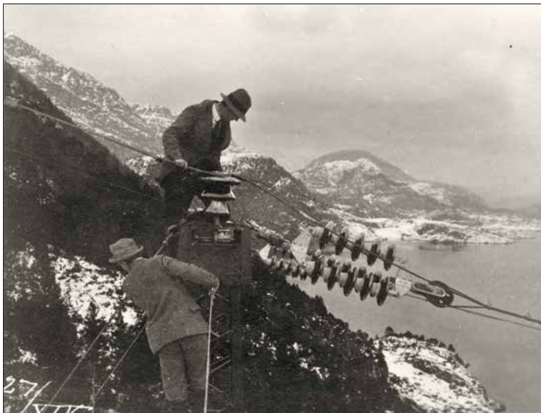
Foto 4. Tilsyn av kraftledningsnettet. Fra Aalfot interkommunale kraftselskaps spennmast ved Nordalsfjorden. Foto: Ukjent/1920-tallet/NVEs fotoarkiv
