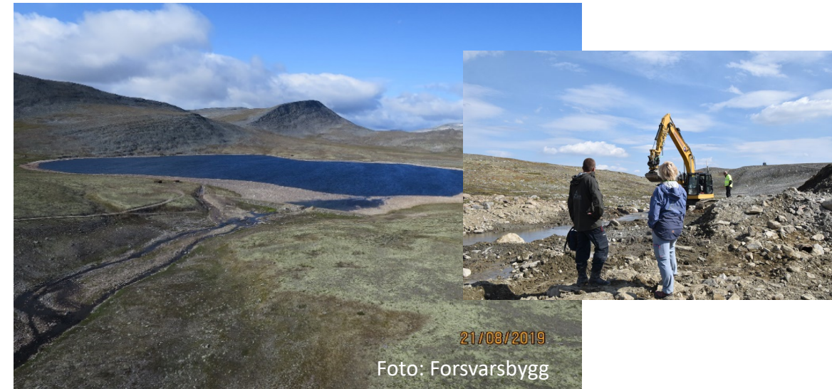
Fjerning av demning ved Einøvlingvatnet: Yes, endelig får fisken vandre fritt, men pent er det ikke....
