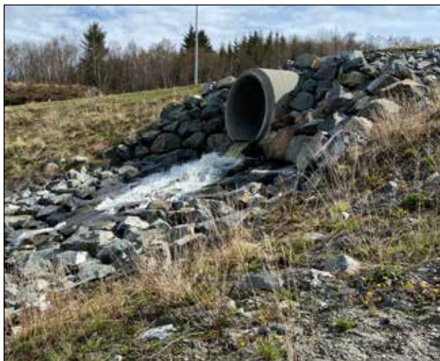
Figur 5AB: Det helt nye veianlegget for FV 710 valgte å ignorere vandringer for fisk i Klakksbekken, slik at vassdraget nå er tapt for laks og sjørret. Vegkulverten ligger like før munningen til sjøen. Tidligere var vassdraget laks- og sjørretførende over en halv kilometer ovenfor veien. Foto fra mai 2020. Foto: Morten André Bergan, NINA.
