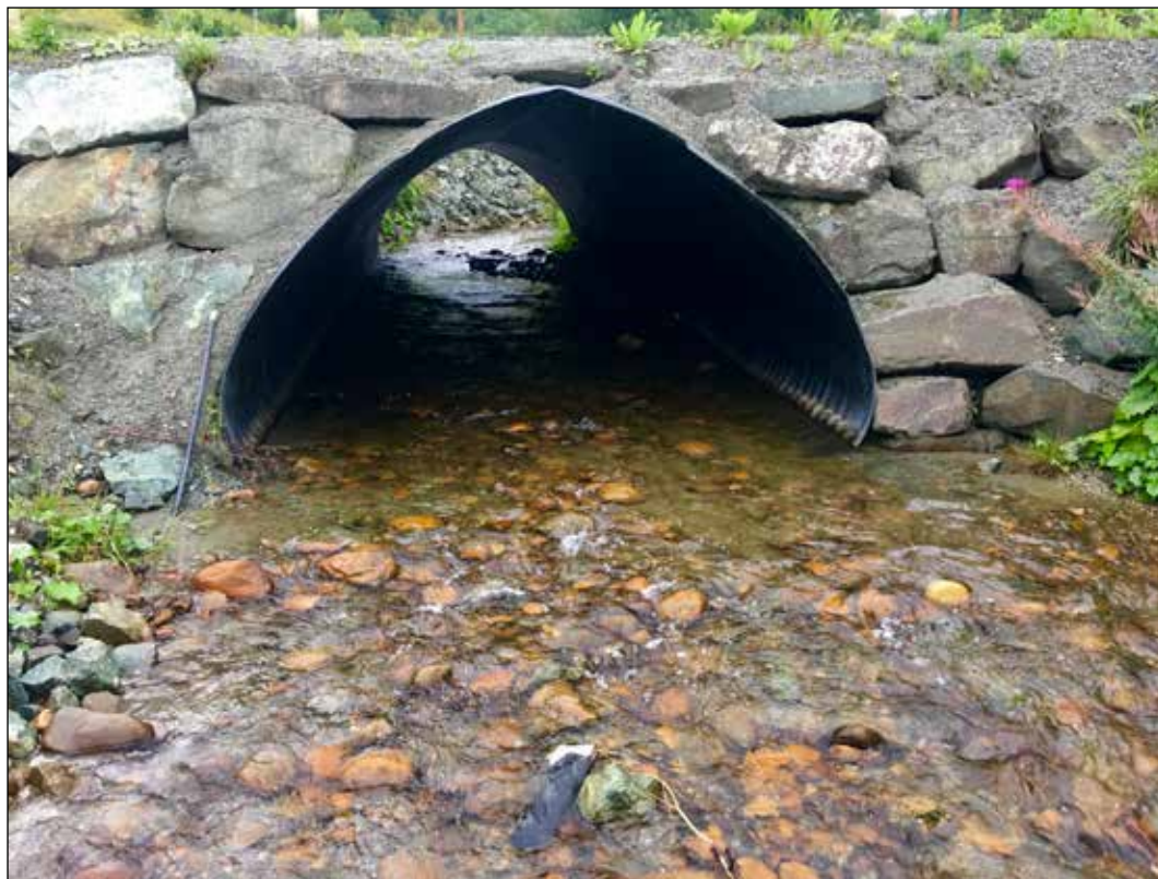
Figur 8. Beste praksis! Et sjeldent syn i Norge. Ny «halvkulvert» under Fylkesvei 6578 Lebergsveien, med bevart bekkebunn og naturlig bekkebredde. Laks, sjørret og ål har siden ca. 2012 kunnet svømme fritt opp og ned i Loa, et viktig sidevassdrag til Gaula i Melhus kommune. Foto: Morten André Bergan (NINA).
