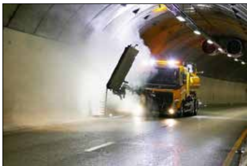
Figur 1: Vask av tunnel i Trondheim, Region midt (Foto: Brynhild Snilsberg, Vegdirektoratet).
