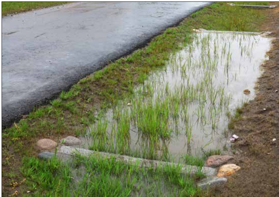
Figur 3. Eksempel på grøft med forsinkelse og med underliggende infiltrationsmagasiner (foto: Forfatteren)
