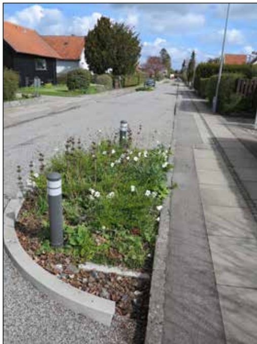
Figur 2. Eksempel på regnbede der indsnævrer kørebanen og giver dæmpning af hastigheden på vejen. (foto: Forfatteren).
