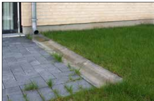
Figur 1 Frakobling av taknedløp og bruk av regnbed kan redusere utfordringene med styrtregn i betydelig grad. (Foto B.C. Braskerud)
