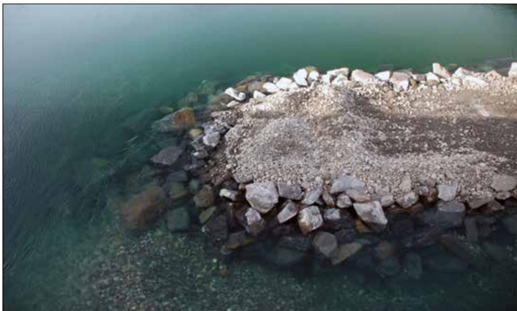
Figur 5. Bilde av steinmoloen under anleggsfasen. Blokkstein er benyttet som såle, mens rullestein og grus ble benyttet som kjøredekke for gravemaskiner og lastebiler. Foto: M. Kraabøl.
