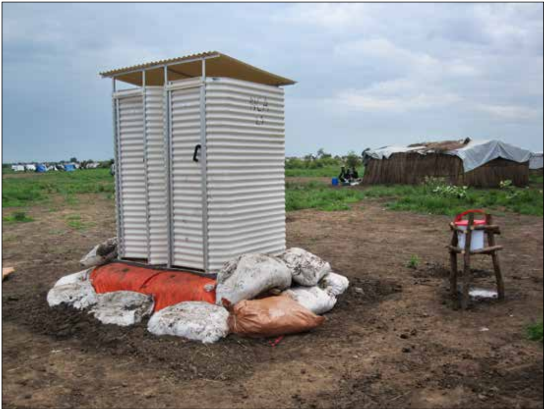
Bilete 1. Døme på ei «dry pit latrine» frå ein flyktningleir i Gambella-regionen i Etiopia: prefabrikkerte korrugerte plastveggar og –tak plassert over ei 2-3 meter djup hole. Latrina er heva over bakkenivå ved bruk av sandsekkar for å unngå at overvatn kjem inn i latrina og bidrar til auka fyllingsraten. Latrina er utstyrt med ein handvaskstasjon i form av ei bøtte med kran plassert i eit stativ lagd av tre like ved.
