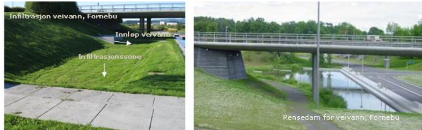
Lokal håndtering av veivann på Fornebu. Venstre foto: Veivannet ledes til en nedsenket infiltrasjonssone oppbygd av selvdrenerende masser. Veivannet siger ned og spres diffust i grunnen (ingen tilknytning til offentlig ledningsnett). Forurensninger i veivannet holdes tilbake i jordmassen. Høyre foto: Veivannet fra 4-felts hovedvei på Fornebu ledes til en rensedam . Forurensningene i veivannet sedimenterer og samles i bunnslammet i dammen. Dammen har et fast vannspeil. (Foto: COWI).
