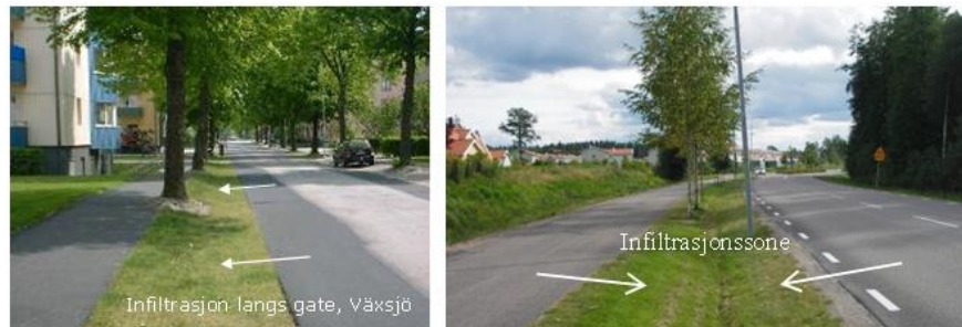
Lokal håndtering av veivann i by. Veivannet ledes til infiltrasjonssoner langs gate/vei. Infiltrasjonssonen er bygd opp av selvdrenerende masser. Sonene kan bygges med overløp til drensledning eller flomvei for å håndtere ekstremisitasjoner. (Foto: Gøran Lundgren).
