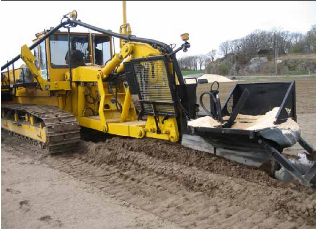
Drenering. Foto: Jon Randby
