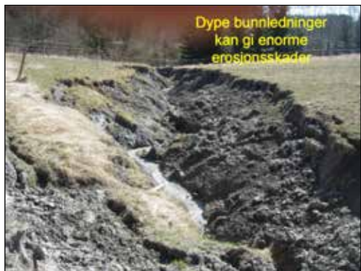
Dype bunnledninger kan gi enorme erosjonsskader. Foto: Atle Hauge
