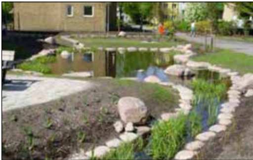
Åpne overvannsløsninger på bakkenivå for å minske regnvann til avløpsnett.
