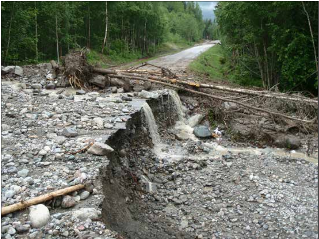
Vegskader. Foto: Ola Næprud
