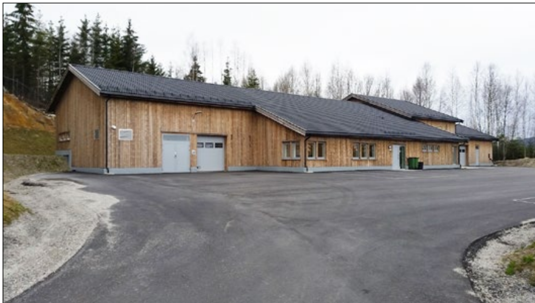
Figur 7. Kirkebygda sentralrenseanlegg. Bygg i energiklasse 1 med vedlikeholdsfritt kebonypanel.
