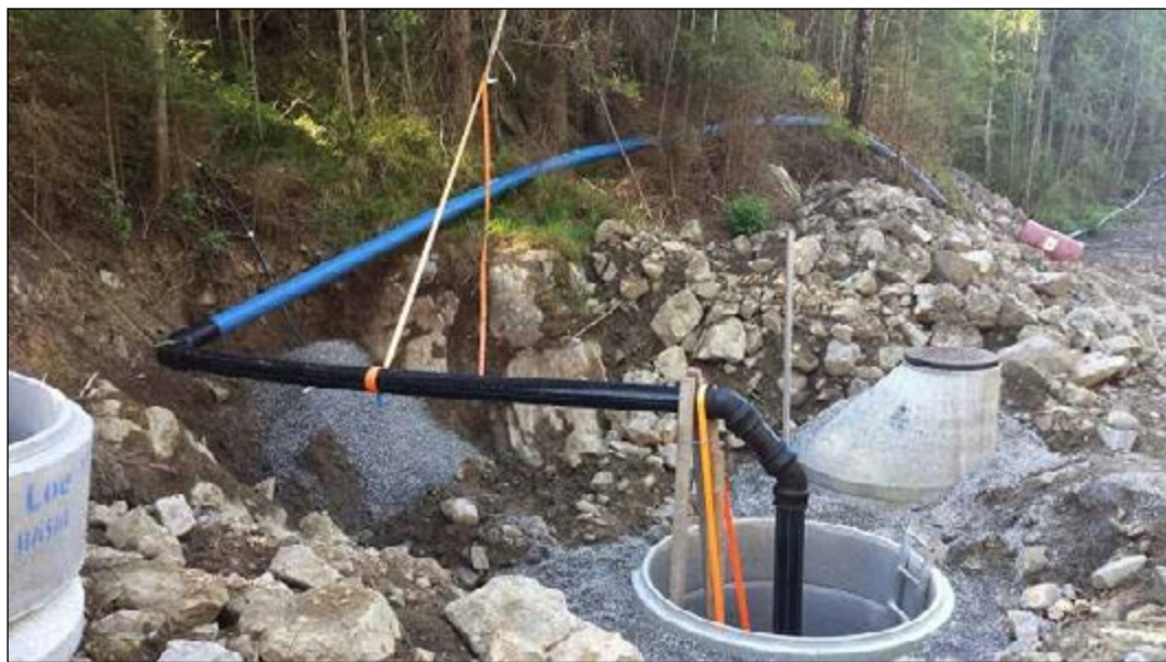
Figur 3. Proledning for vannforsyning til Ytre Enebakk i byggeperioden.
