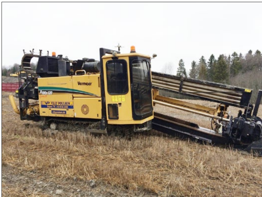
Figur 4. Maskin for boring av utløpsledning over land.
