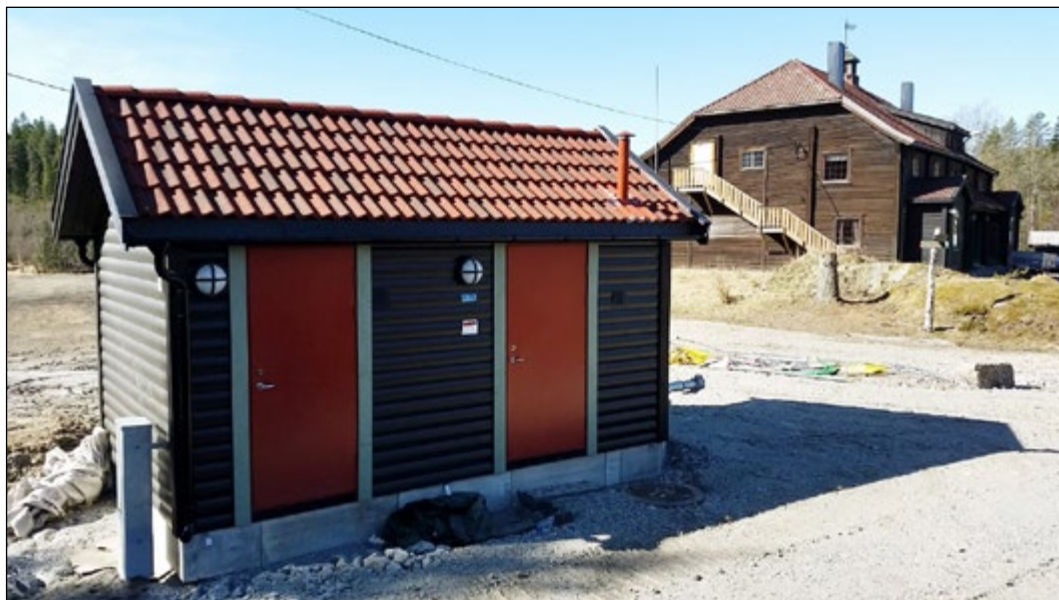
Figur 2. Tømmerbråten pumpestasjon i stil med forsamlingslokalet.
