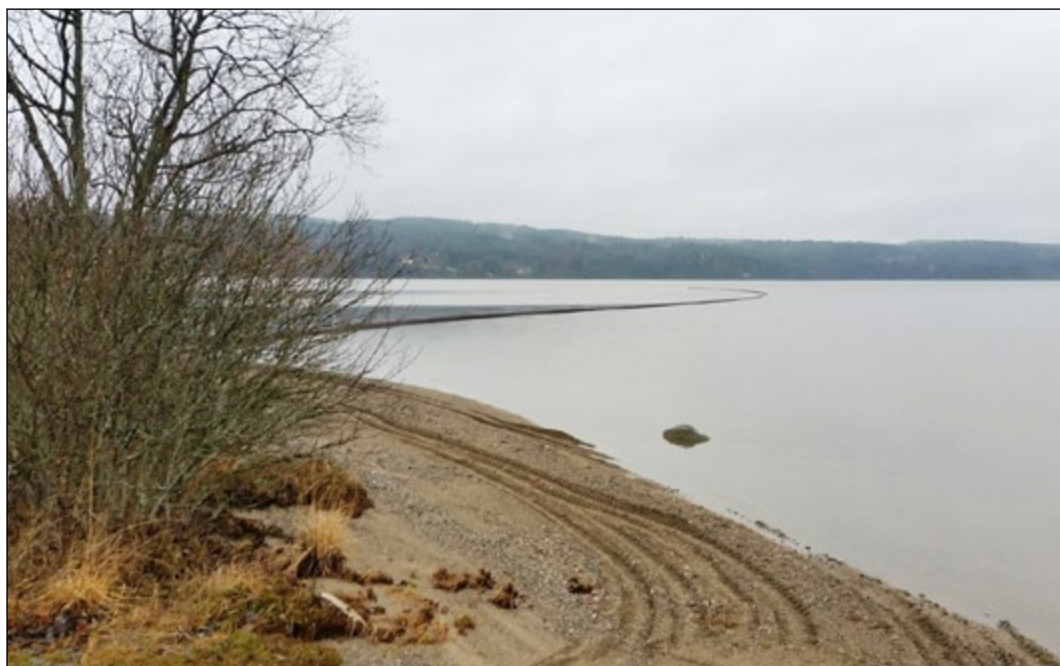
Figur 6. Utløpsledningen ligger som en lang sjøorm ut i Øyeren fra Sandstangen.
