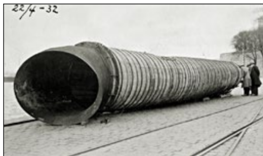
Figur 6. Utslippsledningen lagt i 1931 fra Vippetangen ble revet opp av et skipsanker i 1932.
