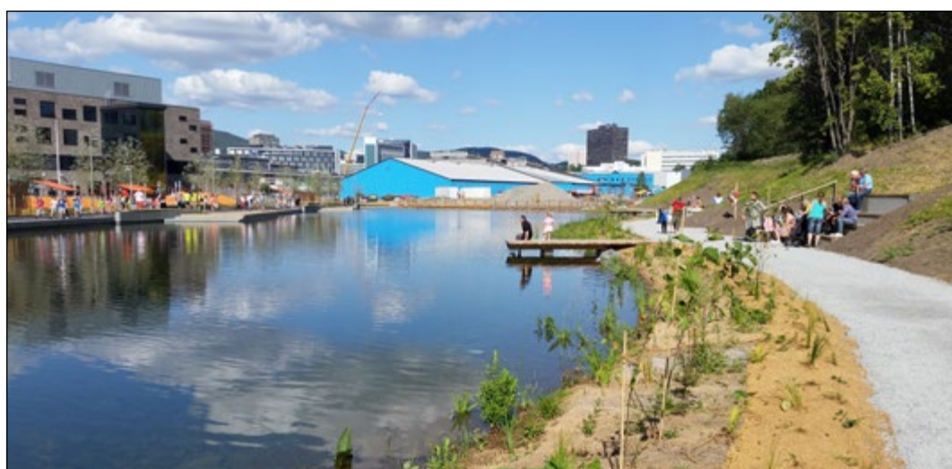
Figur 1. Befaring ved Teglverksdammen, Oslo. Under bygging og ved åpningen. (Foto: Anders Iversen).
