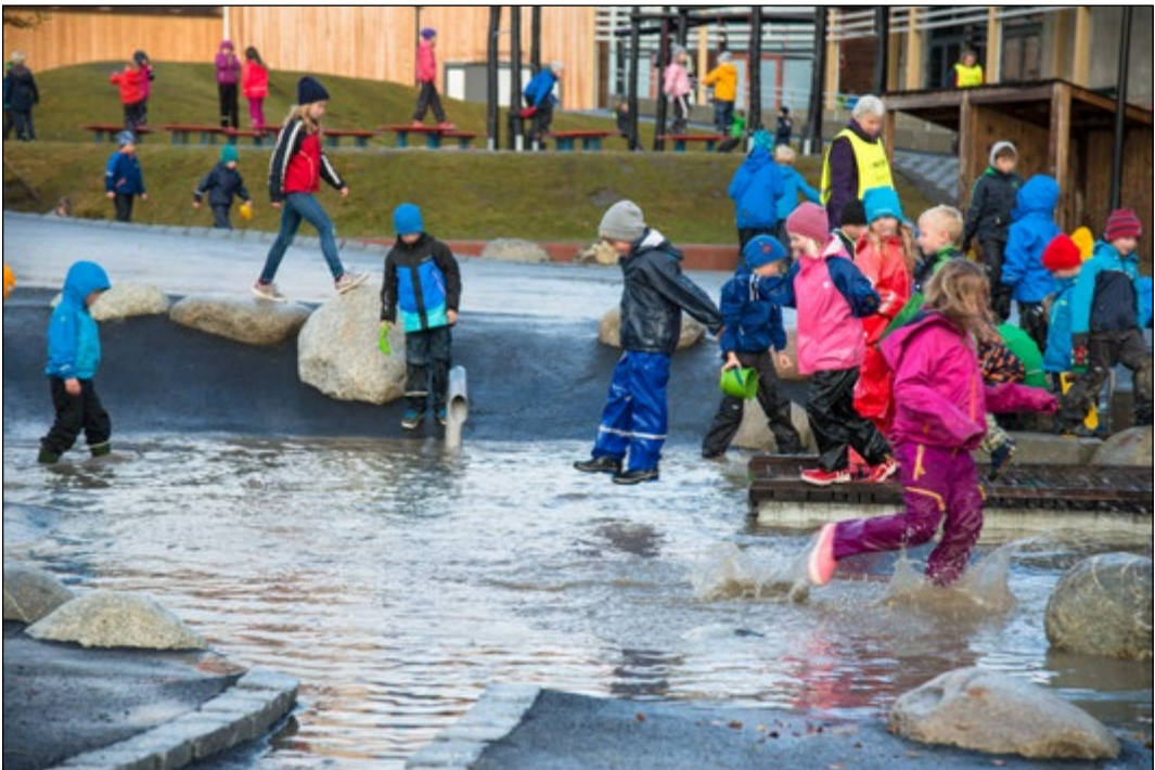
Bilde nr. 2. Full fart i vannleken. Midt på bildet ses et av rørene hvor takvannet kommer ut til overflata og går ut i dammen.
