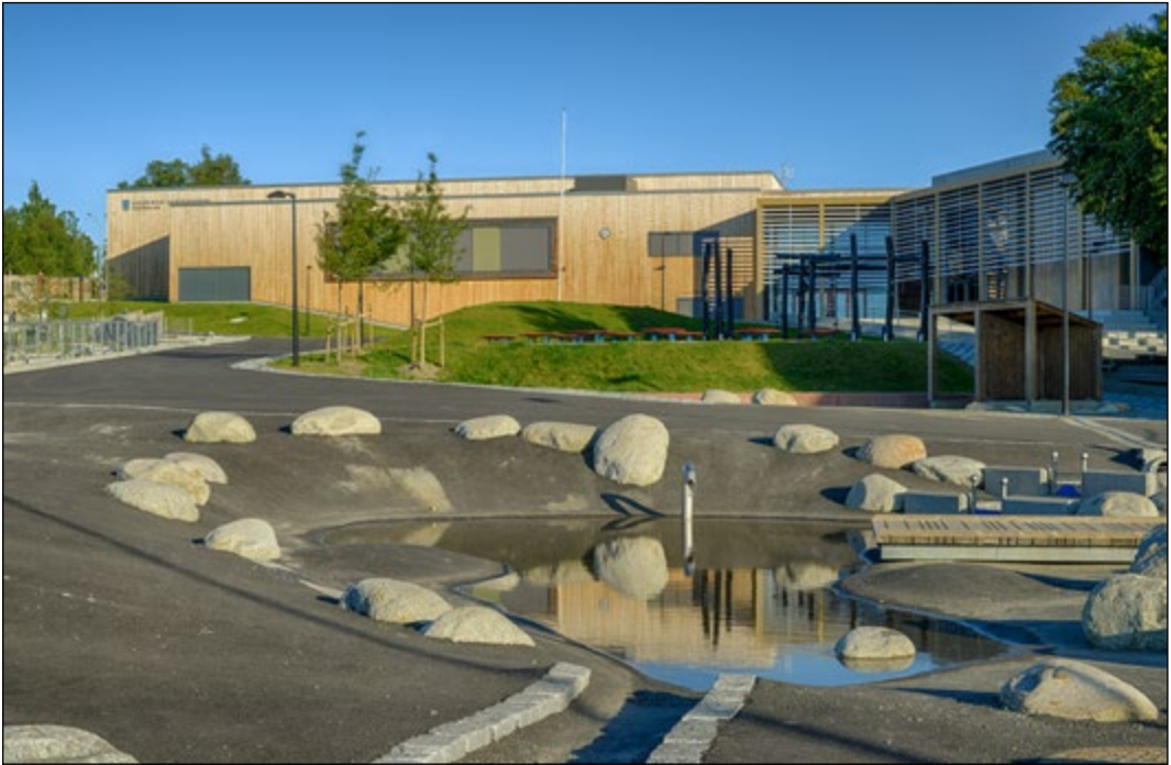
Bilde nr. 1. Lokal overvannshåndtering ved Åsveien skole betyr både teknisk fordøyning, lek og estetikk.
