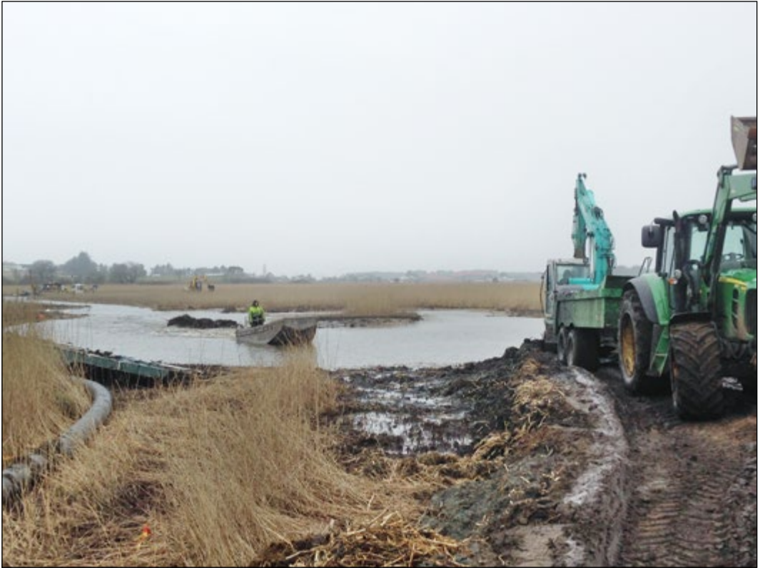
Bilde nr. 4. Mudringsmasser trekkes på flåte inn til land (Foto: Eivind Hellerslien).
