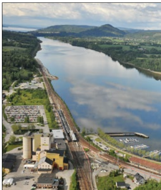
Figur 1. Vorma sett mot nord med Eidsvoll stasjon i forkant. Planområdet og eksisterende jernbanespor ligger vest for Vorma.
