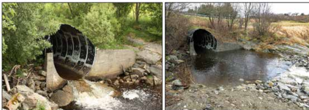
Figur 4. Eksempel på løsning/tilstand før og etter utbedring. Ulvangselva på Helgeland. Foto: Lars Aage Gade-Sørensen, Statens vegvesen Region nord.
